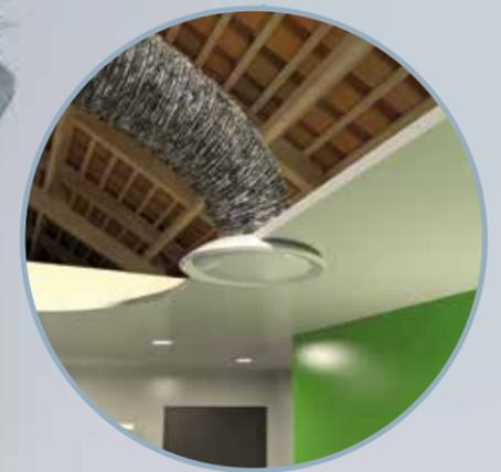
**Les bouches d'insufflation** apportent air neuf et réel confort thermique.
